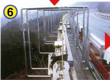
足場板敷き込み
