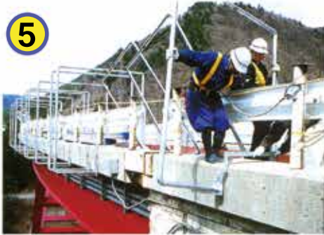
フープ枠取付
