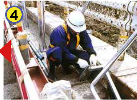
地覆バンドをフープ枠に連結
